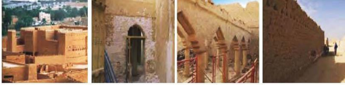
ترميم الوجوهات ترميم الأطلال ترميم والتأهيل الترميم الكامل
